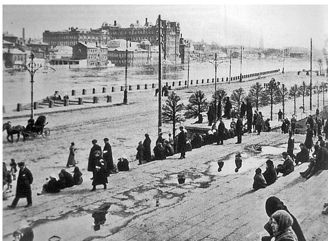
Widok fabryki Einema od strony soboru Chrystusa Zbawiciela
